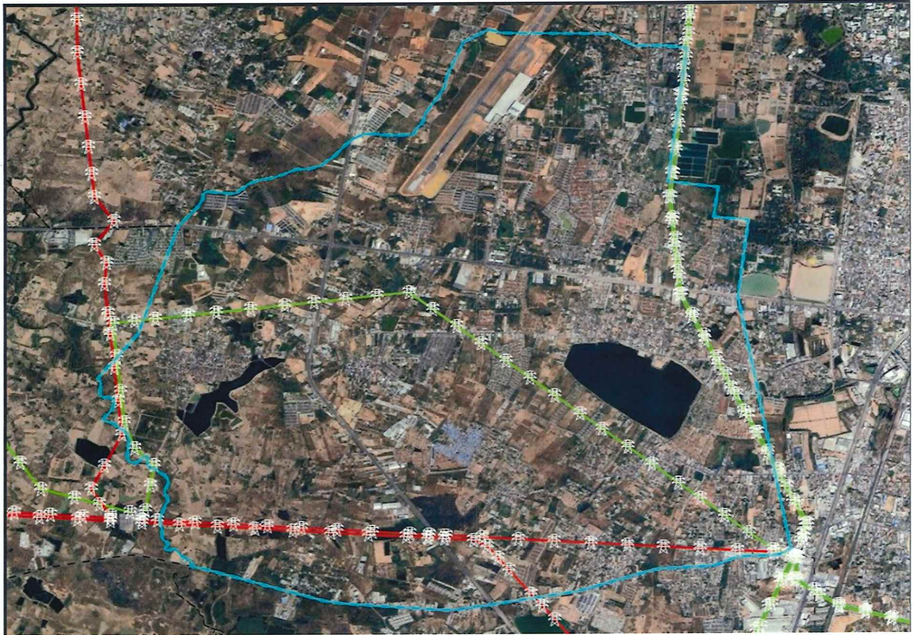
พื้นที่แนวสายส่งไฟฟ้าแรงสูงของ กฟผ. พาดผ่านเทศบาลตำบลบ้านเป็ด
